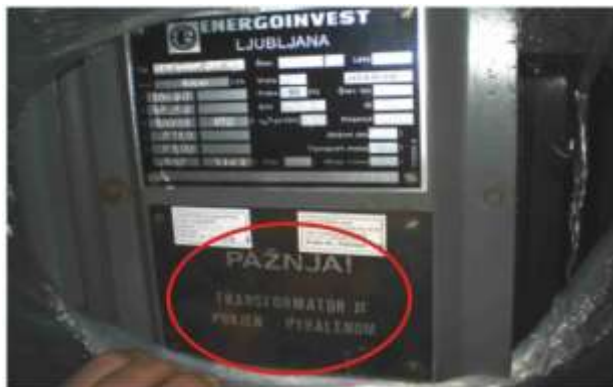
СЛИКА 2 – Идентификациона плоча са јасним упозорењем на присуство загађеног уља
