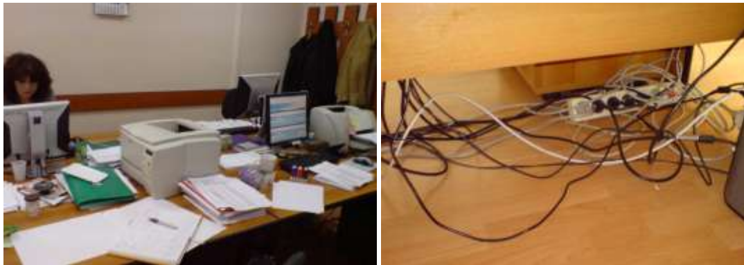
Слика 1: Чест изглед радних столова и снопа каблова испод њих, продужени каблови
