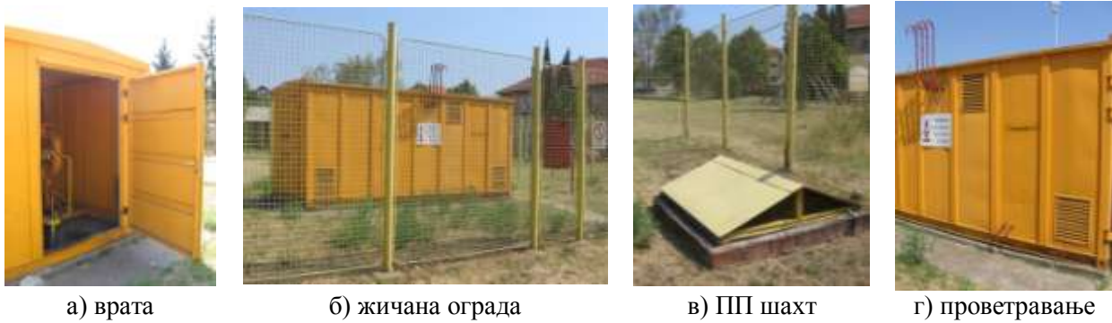
Слика 3 – Правила пројектовања и извођења МРС у циљу безбедности на раду
