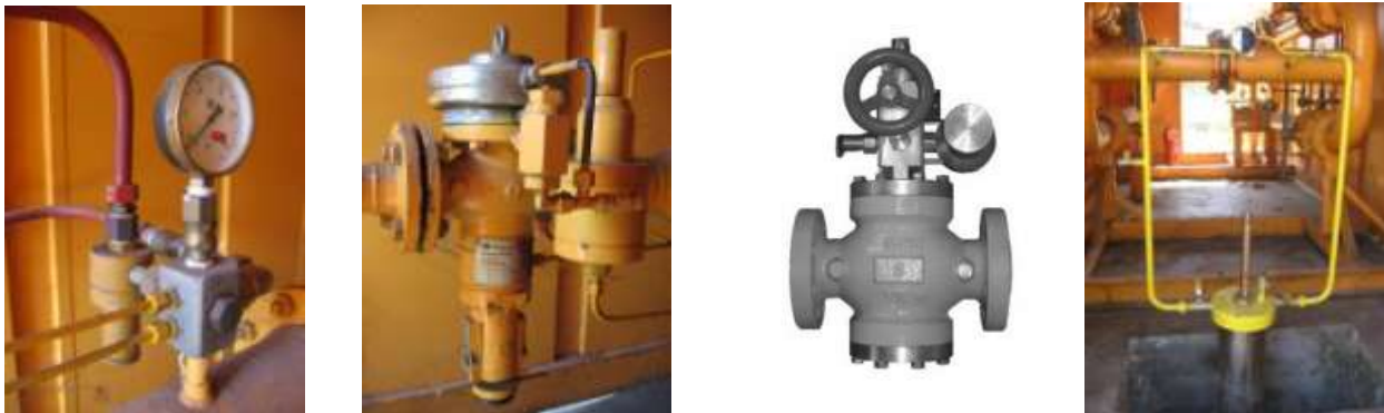
Слика 5 – Сигурносна опрема уграђена у МРС (вентил сигурности, регулатор притиска, блокадни вентил, одоризатор гаса)
