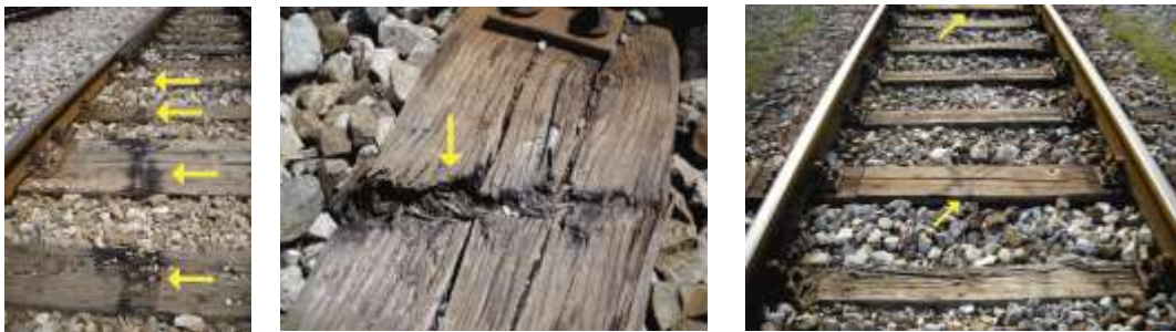
Слика 9. Трагови од железничке несреће и излаза воза с трачница (деоница Скопље – Тетово, на 1 км од железничке станице у Тетову, 2012 године).
