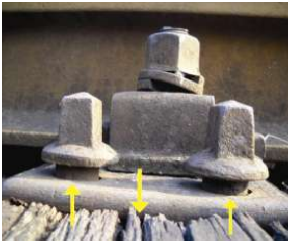
Слика 2. Урезаност подложне плочице у праг (лево), те штање и „искакање” тирфона због трулости прага (десно).
