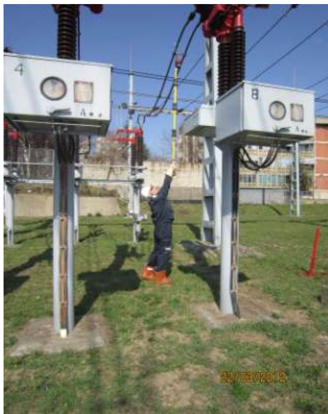
Слика 7. Провера исправности индикатора Слика 8. Провера безнапонског стања
