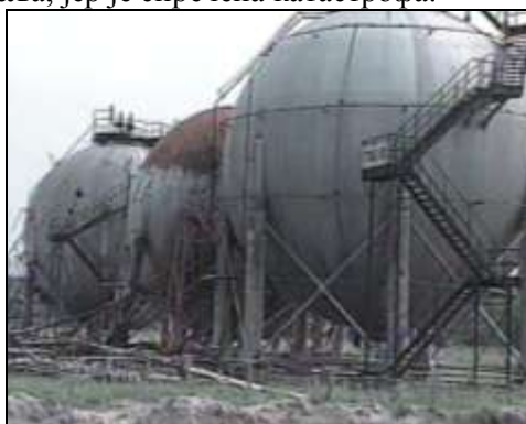
Слика 1 – Оштећени носачи сферног резервоара (у средини) 2
