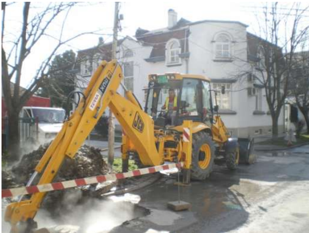
Сл.2 Машински ископ земљаних материјала на привременом градилишту
