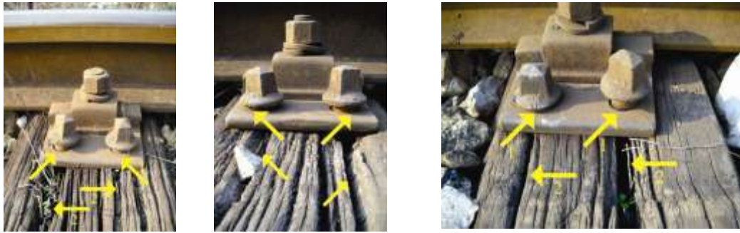
Слика 7. Пролупани тирфони на трулим и јако распуцаних прагова (деоница Скопље - Тетово).
