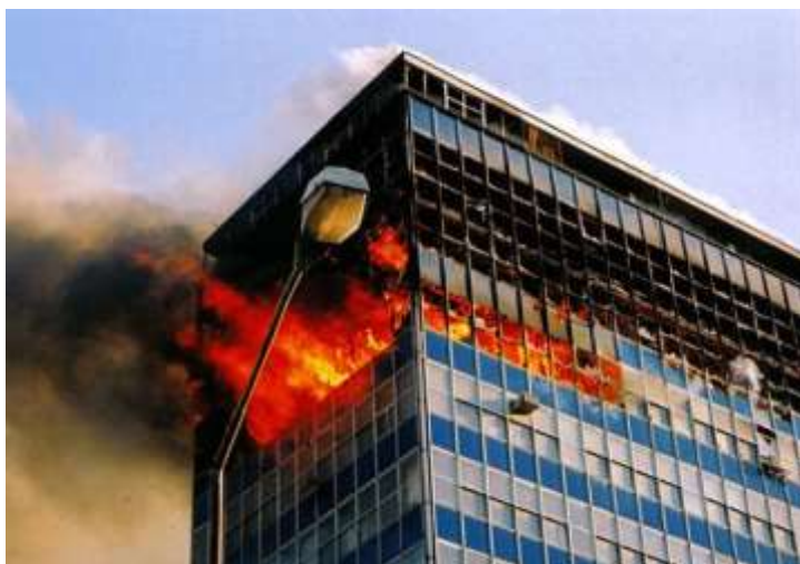
Слика 1. Тешке последице пожара на згради Радничког универзитета у Новом Саду (2000.), резултат великог архитектонског непознавања ефеката пожара
