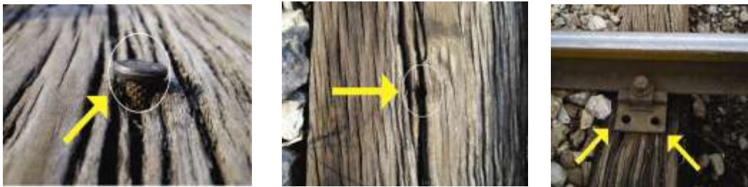
Слика 8. Искакање клинских жигова и тирфона код трулих прагова.
