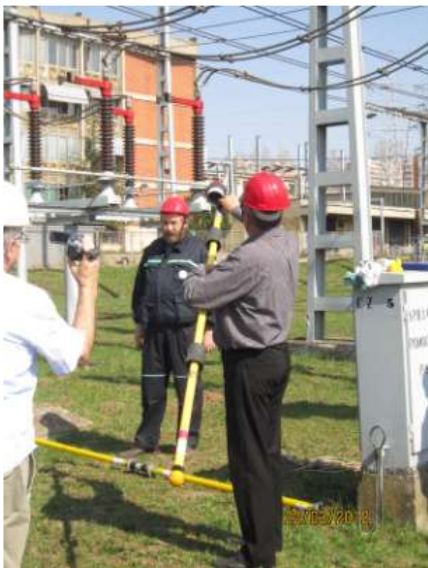
Слика 7. Провера исправности индикатора Слика 8. Провера безнапонског стања
