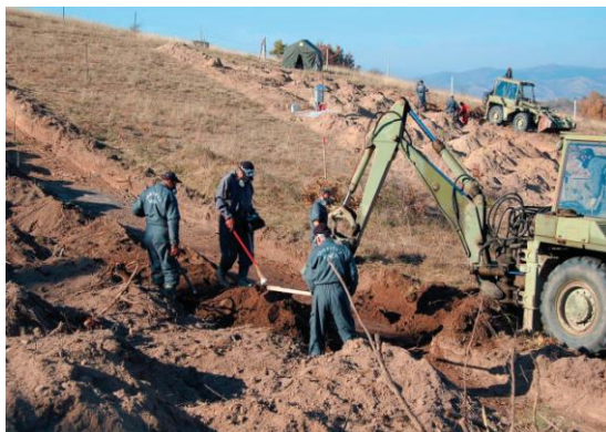
Slika 4 – Dekontaminacija zemljišta upotrebom inženjerskih mašina
